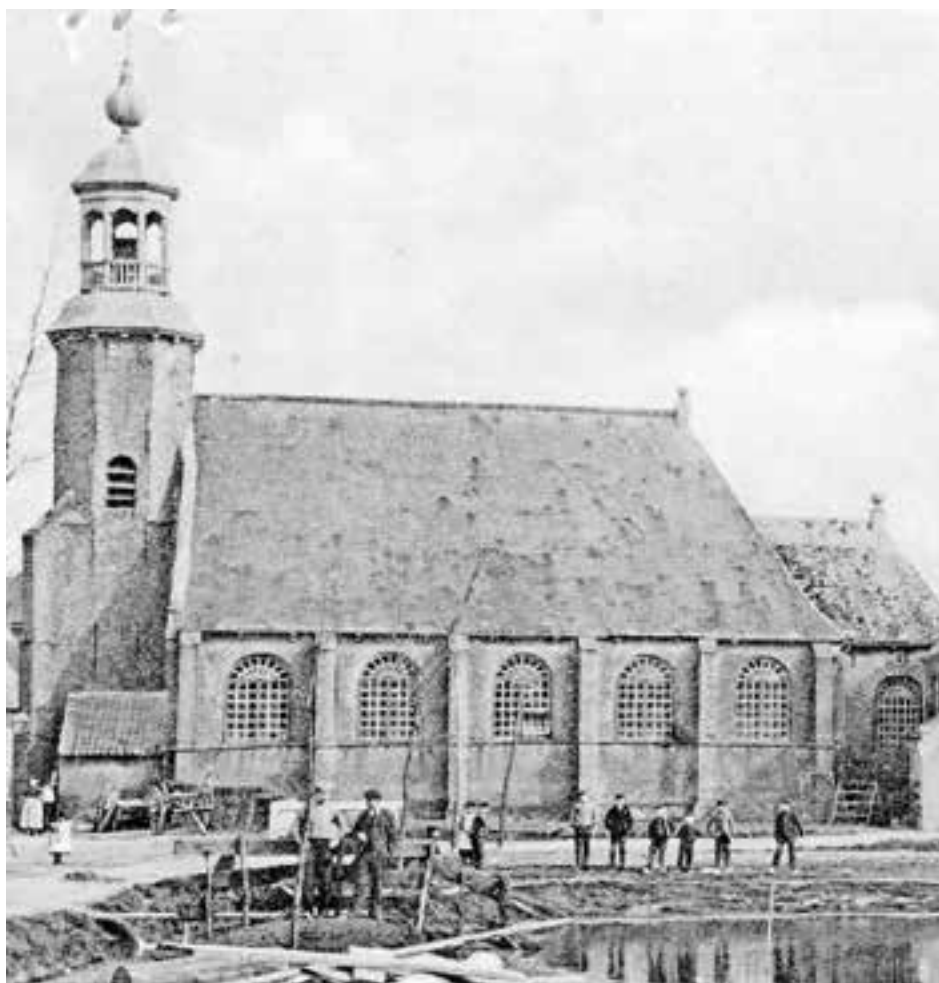
De oude hervormde kerk in 1905. Ervoor worden grond- en rioleringswerken uitgevoerd.
